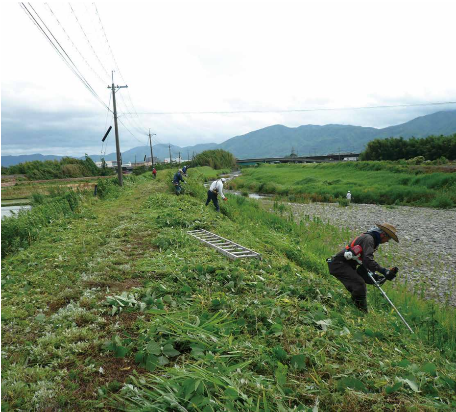
犬飼川左岸堤防の草刈り
